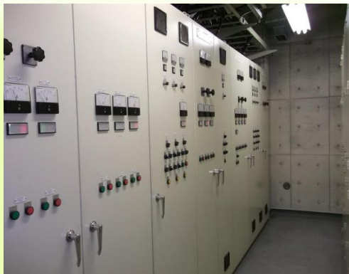
■給水施設点検
