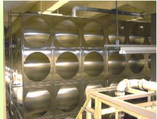
■ 受水槽設置工事
