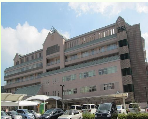
■ こども医療センター熱源改修工事
