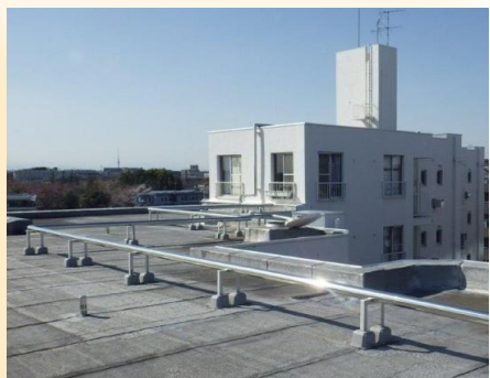
■屋外給水管改修工事
