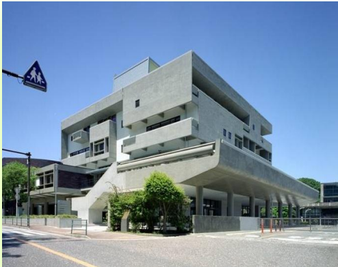
■ 青少年センター空調工事
