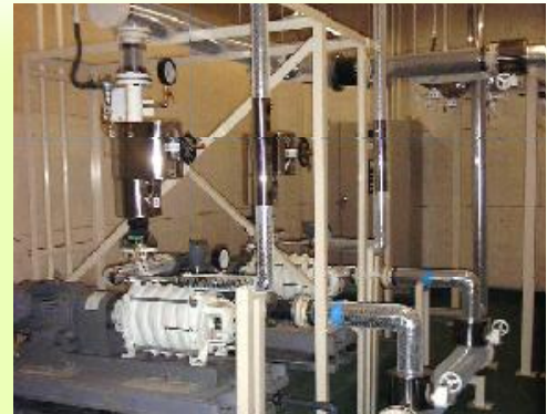
■ ポンプ廻り配管工事
