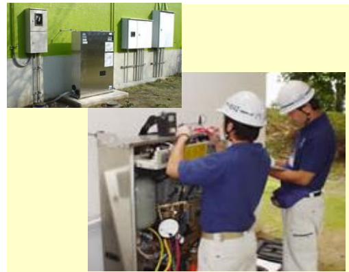
■給水ポンプ点検
