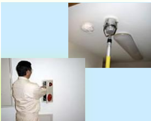
■消防設備点検
