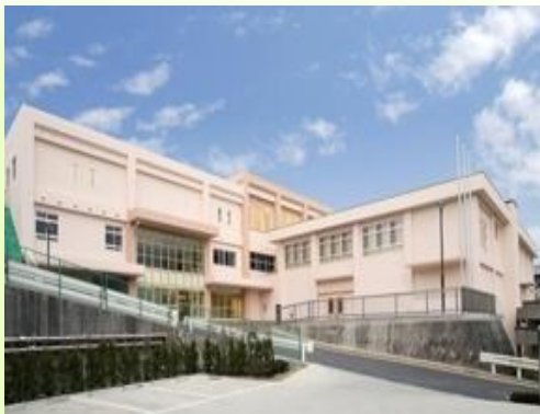
■ 川崎北部養護学校新築工事（空調）
