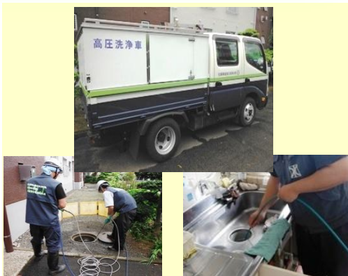
■排水管高圧洗浄によるツマリ予防と衛生管理
