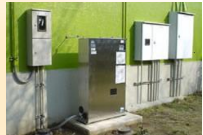
■給水直結増圧化工事
