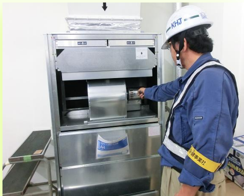
■空調設備点検
