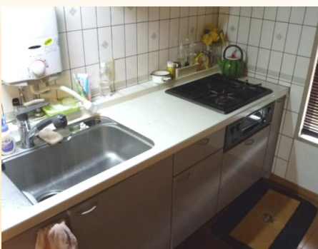
■リフォーム工事
