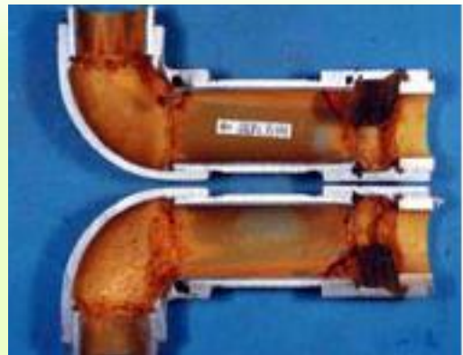
■給水管の抜管調査
