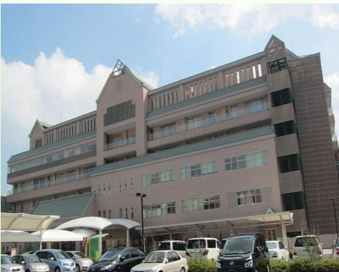
■ こども医療センター熱源改修工事
