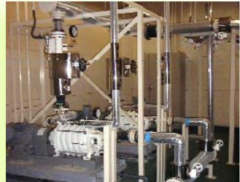
■ ポンプ廻り配管工事
