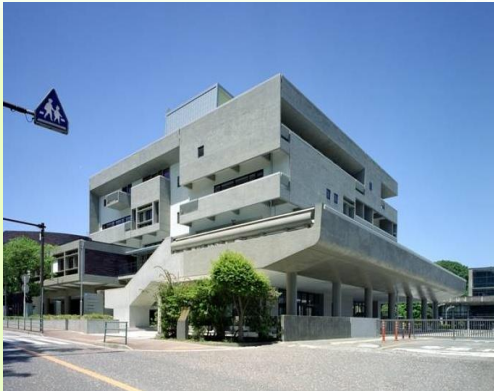
■ 青少年センター空調工事
