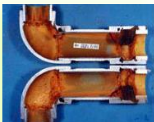
■給水管の抜管調査
