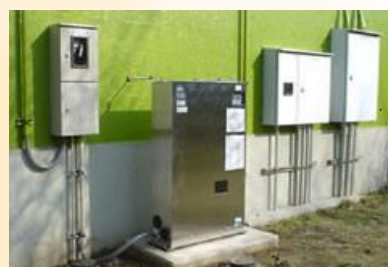
■給水直結増圧化工事
