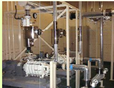
■ ポンプ廻り配管工事
