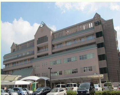
■ こども医療センター熱源改修工事
