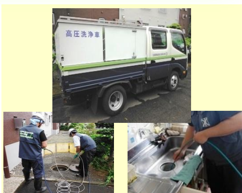
■排水管高圧洗浄によるツマリ予防と衛生管理
