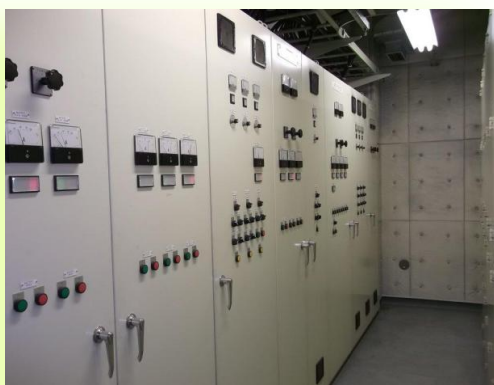
■給水施設点検
