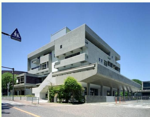
■ 青少年センター空調工事
