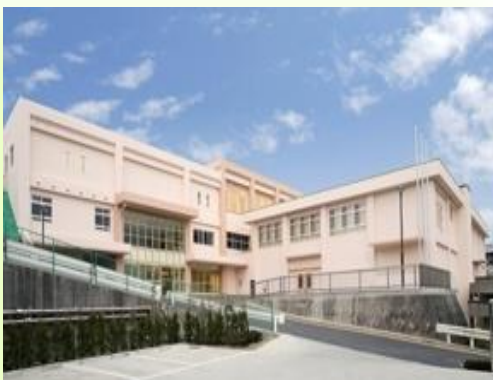
■ 川崎北部養護学校新築工事（空調）
