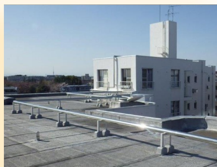
■屋外給水管改修工事
