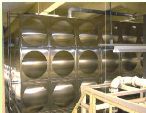
■ 受水槽設置工事
