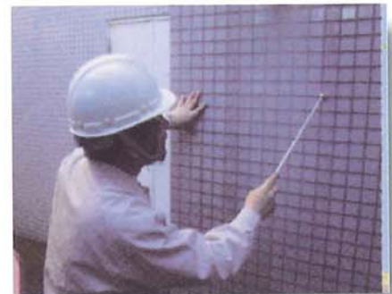
建築仕上診断技術者による外壁診断
