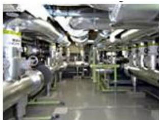
空調設備配管工事
