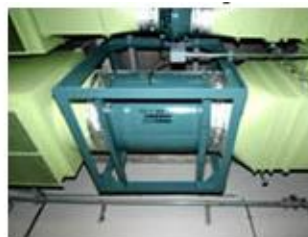
換気ダクト設備工事
