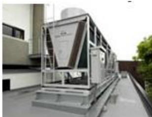
空調機械設置工事
