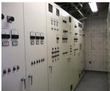
〈給水施設点検〉
